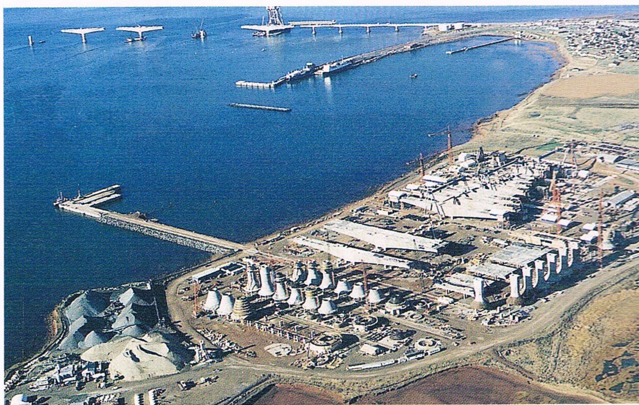
De bouwplaats op het eiland met de bruggdelen in verschillende stadia van wording.
