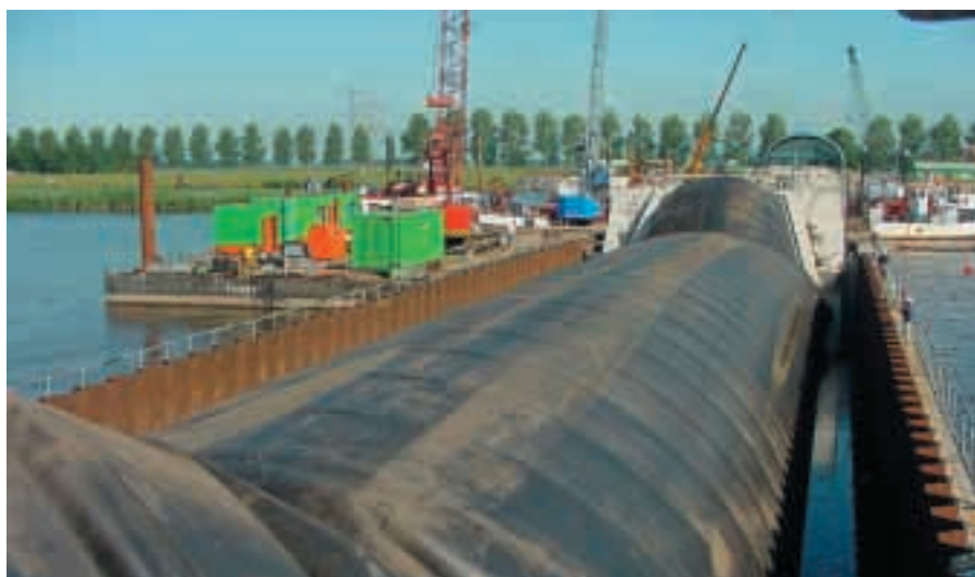
De balgstuw in een afgesloten kuip, gevormd door twee dammen, in de zomer van 2001.
