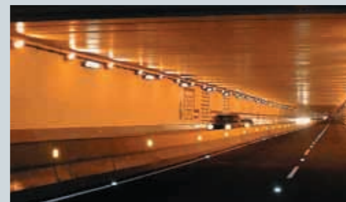
Een lichte kleur op de tunnelwanden maakt de overgang van buiten naar binnen makkelijker.
