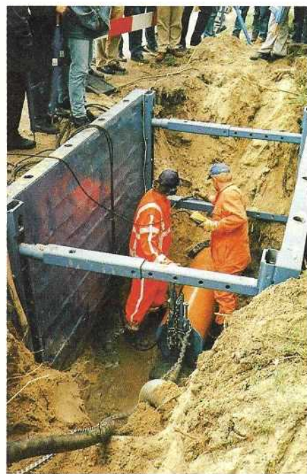
Vervanging van oude riolering door PVC-buis met de 'buisenkraak'-methode.
