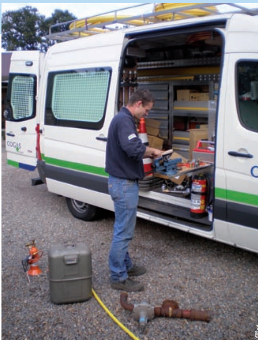
De gasleidingen die dateren uit de jaren zestig van de vorige eeuw zijn aan vervanging toe. In dit werk wordt de komende decennia voor honderden miljoenen euro's geïnvesteerd.
