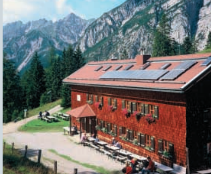
De Maagdenburghut in het Oostenrijkse Karwendelgebied heeft 1,5 kW zonnecellen op het dak, voldoende voor de dagelijkse elektriciteitsbehoefte van 5 kWh.
