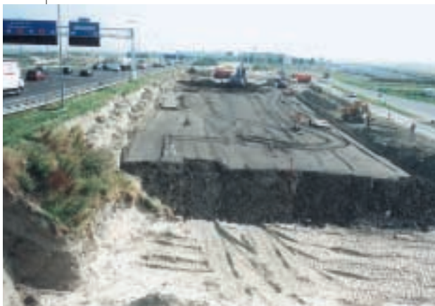
De aanleg van het proefvak bij Schiphol. Op de voorgrond gewoon zand, daarachter gerijpte baggerspecie.
